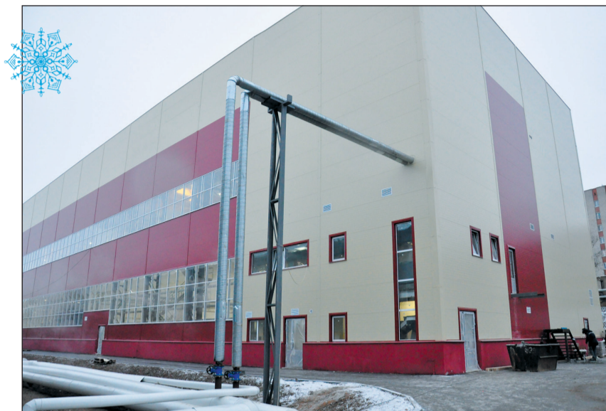
Завершается строительство нового цеха
